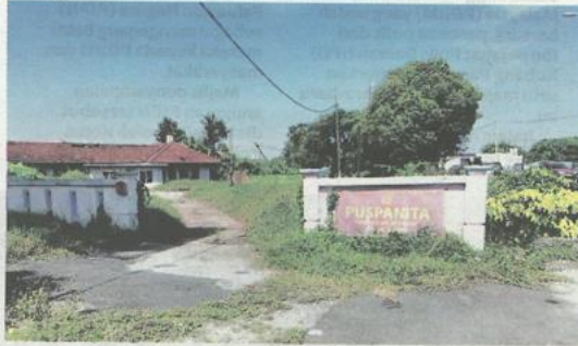
KEADAAN bangunan Rumah Puspanita Hilir Perak yang semak dan terbiar ketika tinjauan di Teluk Intan, Perak, baru-baru ini. - UTUSAN/AIN SAFRE BIDIN
