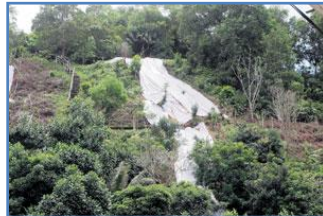
KEADAAN cerun bukit yang terhakis akibat hujan lebat baru-baru ini di Bandaran Berjaya, Kota Kinabalu.
