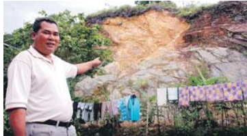
Solehin Kosasi menunjukkan rekahan pada bukit di sebelah pangsapuri Seri Impian, Ukay Perdana Dua, Hulu Kelang, Selangor Ahad lalu.
