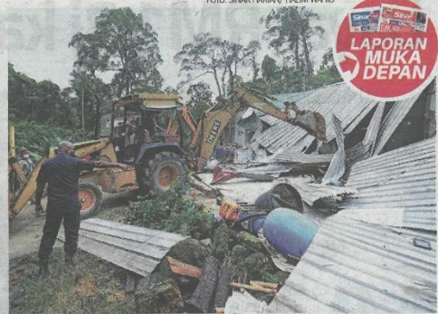
Sebuah rumah yang didirikan di kawasan hutan simpan Bukit Lagong dirobohkan menerusi Operasi Bersepadu Ops Langat pada 28 September lalu.
