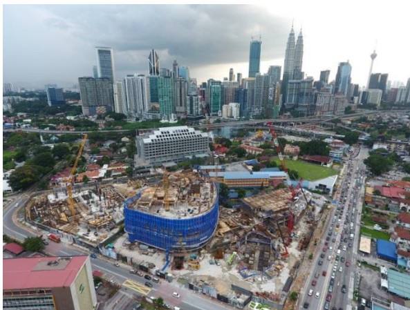
TAPAK projek pembangunan Kuala Lumpur Vertical City (KLVC) di Jalan Semarak, Kuala Lumpur. -
