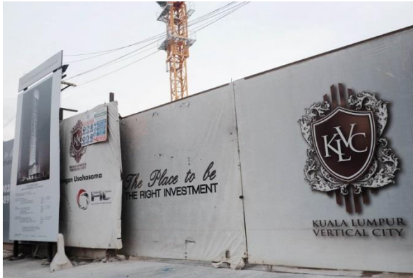
TAPAK projek pembangunan Kuala Lumpur Vertical City (KLVC) di Jalan Semarak, Kuala Lumpur. -
