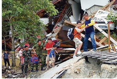
PASUKAN keselamatan membantu penghuni kondominium berhampiran menyelamatkan diri berikutan kejadian tanah runtuh di Bukit Antarabangsa, Hulu Klang, kelmarin.
