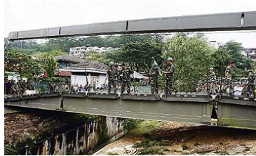
ANGGOTA Tentera dari Kor Kejuruteraan DiRaja Tentera Darat memasang jambatan sementara Vickers BR90 bagi menyambungkan laluan terputus akibat kejadian tanah runtuh.
